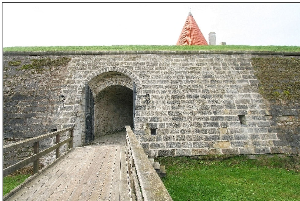
Ill. 10. 2014.a. puhastatud ja vuugitud müür Põhjabastioni väravakäigu kohal.
